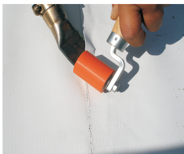
Рис. 4. Второй проход при ручной сварке
