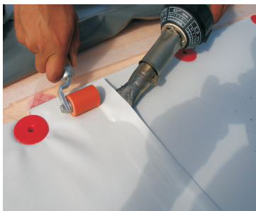
Рис. 3. Первый проход при ручной сварке
