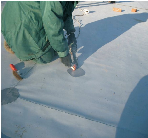
Рис. 5. Установка заплатки
