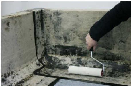
Рис. 14. Укладка геотекстиля с правой стороны от угла парапета. Выкройка соответствует зеркально отраженной форме рис.17.
