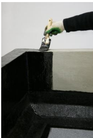
Рис. 11. Нанесение второго слоя мастики на левую сторону от угла парапета.
