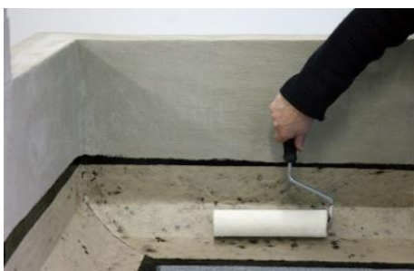
Рис. 10. Прикатывание геотекстиля к поверхности валиком после укладки.
