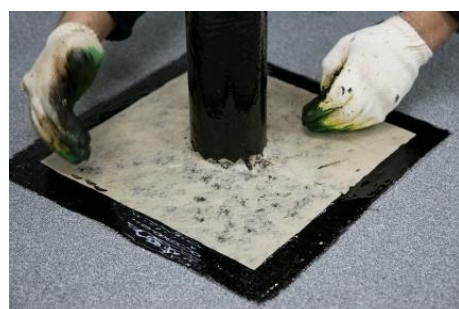
Рис. 22. Укладка геотекстиля по свеженанесенной мастике. Выкройка соответствует форме рис. 25.
