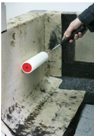
Рис. 12. Укладка геотекстиля слева от угла парапета. Выкройка выполнена предварительно в соответствии с формой, изображенной на рис.17.
