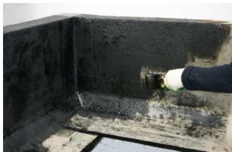
Рис. 15. Нанесение третьего слоя мастики поверх геотекстиля с «запечатыванием» его торцов за счет захода на неармированную поверхность (см. рис.5).
