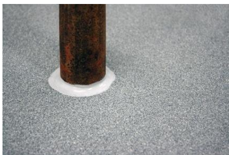
Рис. 20. После нанесения герметика его поверхности придается форма галтели.
