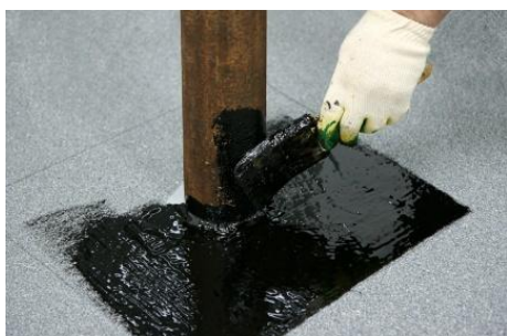
Рис. 21. Нанесение первого слоя мастики. Операция выполняется после образования пленки на поверхности герметика (2-3 часа в летний период).
