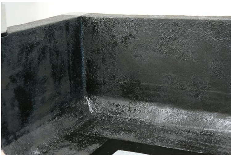
Рис. 16. Вид внутреннего угла примыкания после нанесения покрытия.
