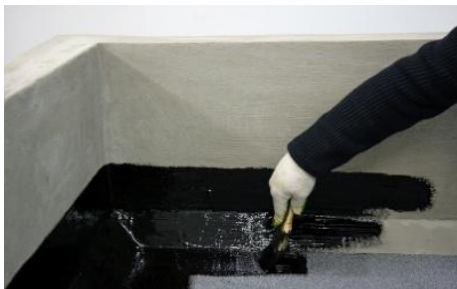
Рис. 9. Нанесение первого слоя мастики на область галтели.
