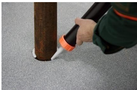
Рис. 19. Заполнение шва вокруг трубы полиуретановым герметиком Рабберфлекс.
