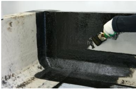
Рис. 13. Нанесение второго слоя мастики с правой стороны от угла парапета.
