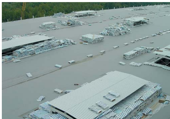
Строительство завода по производству керамической плитки. Система ALKORPLAN с механическим способом крепления к основанию (Московская область, 2005).
