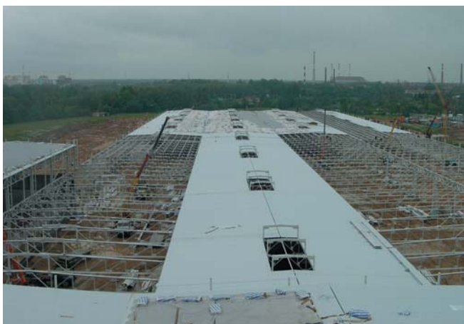
Строительство завода по производству керамической плитки. Система ALKORPLAN с механическим способом крепления к основанию (Московская область, 2005).
