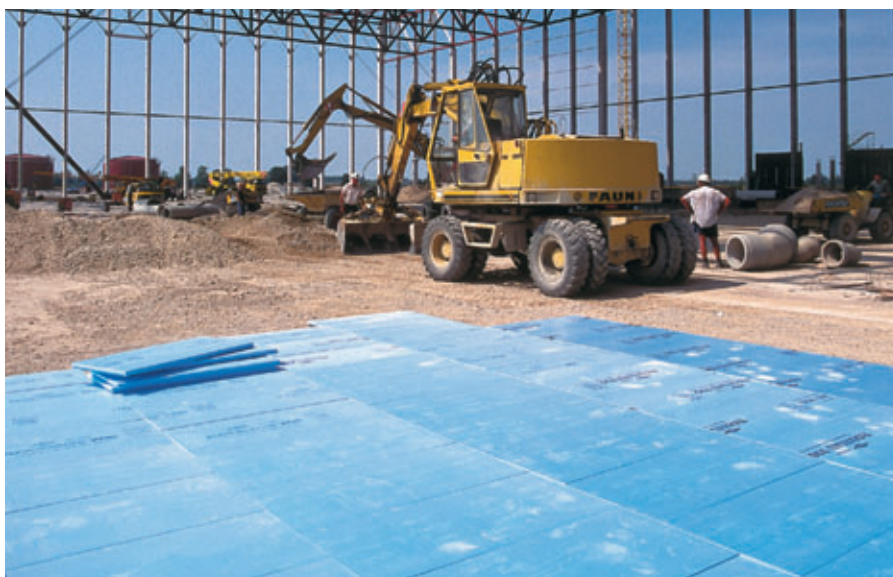
Аэропорт в Мюнхене, теплоизоляция пола в ангаре.
