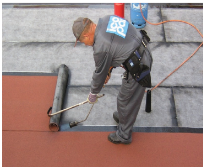
Рис. 13 Укладка верхнего слоя материала наплавлением
