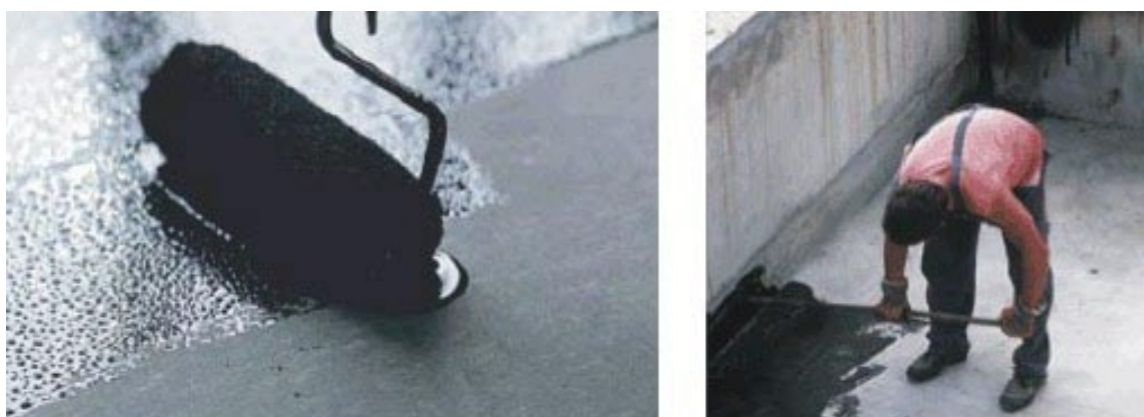
Рис. 5 Нанесение праймера
