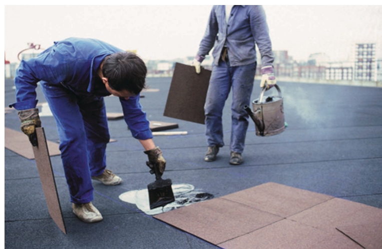
Рис. 12 Укладка плиток Dalle Parcours
