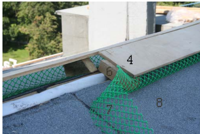
Рисунок 3.26. Конёк однослойной кровли с продухом.
