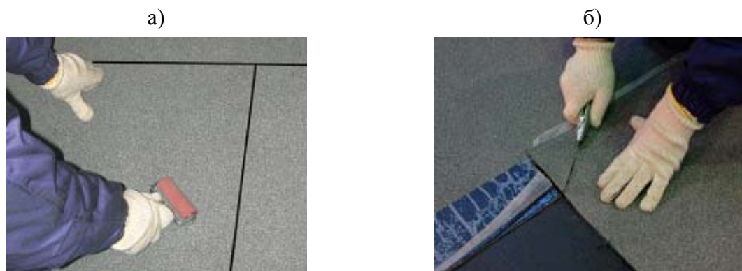
Рис. 3.6. Прикатка нахлестки силиконовым валиком (а); обрезка угла торцевой кромки полотнища (б).
