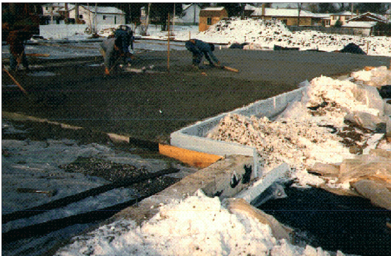
Рисунок 7.8 Укладка бетонной смеси
