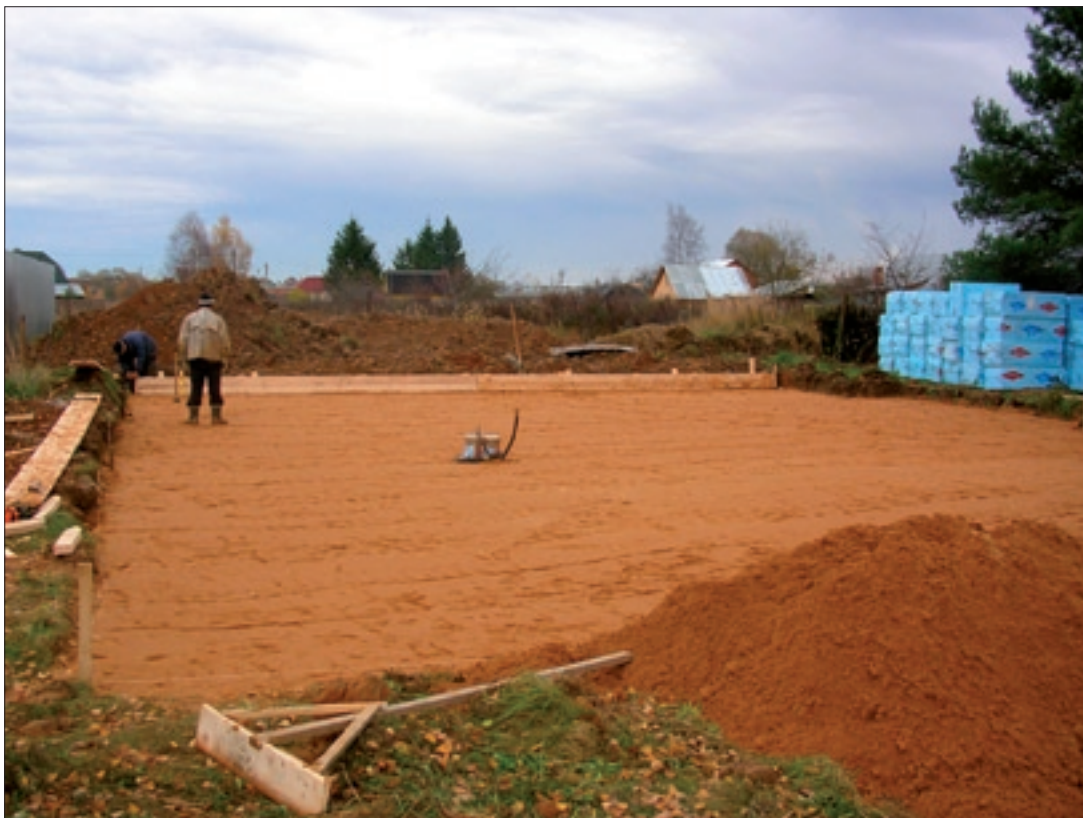
Рисунок 7.2 Уплотнение грунта до укладки теплоизоляции STYROFOAM GEO
