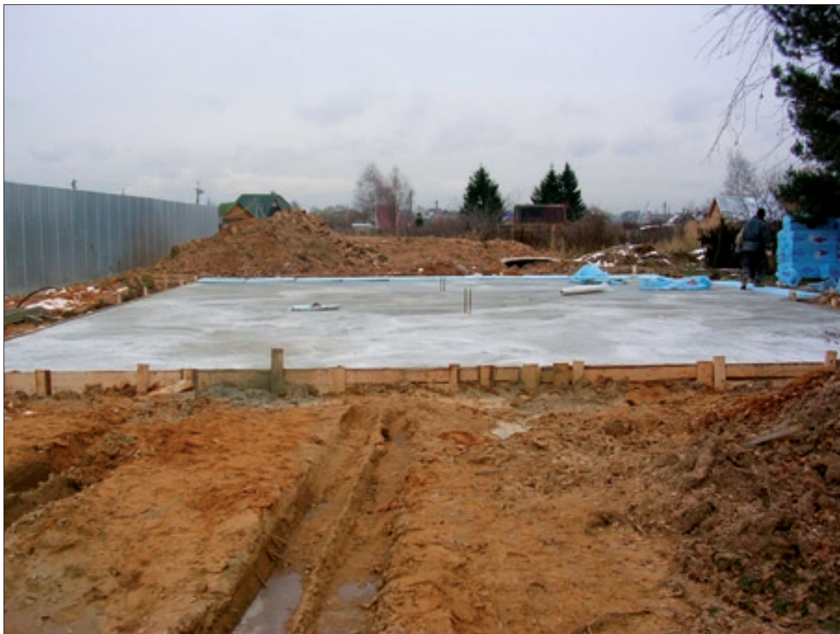
Рисунок 7.9 Уход за бетоном
